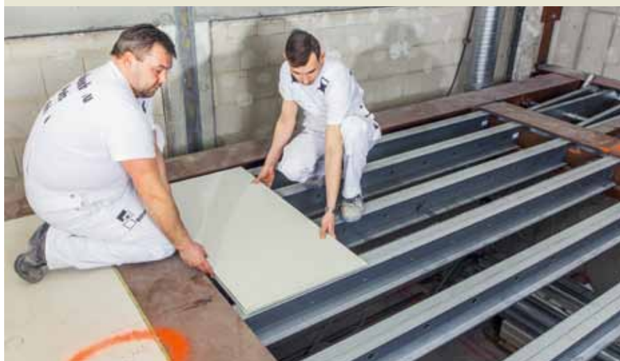
Nicht nur Schallschutz, auch Brandschutz. Auf die Stahlbaukonstruktion wurden die Gipsfaser-elemente Gifaflor 32 mm schwimmend verlegt. Für das Gesamtdeckensystem mit Stahlprofilen und Gipsfaserplatten gab es eine brandschutzrechtliche Zustimmung F90 im Einzelfall.
