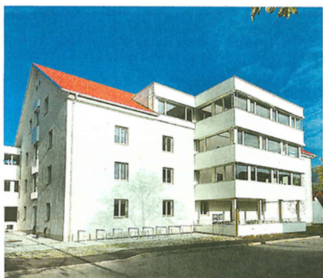
Zwölf Bewohner sind bereits im „Haus 1“ eingezogen, zehn weitere folgen im Jänner 2016.
